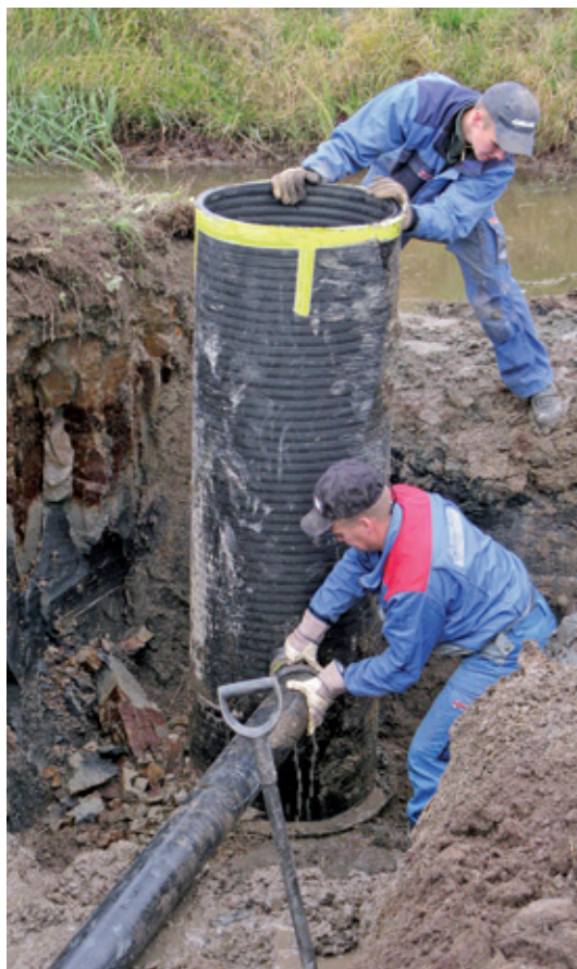
Kuva vasemmalla: Säätökaivon asennus tyypilliselle sulfaattimaalle.
